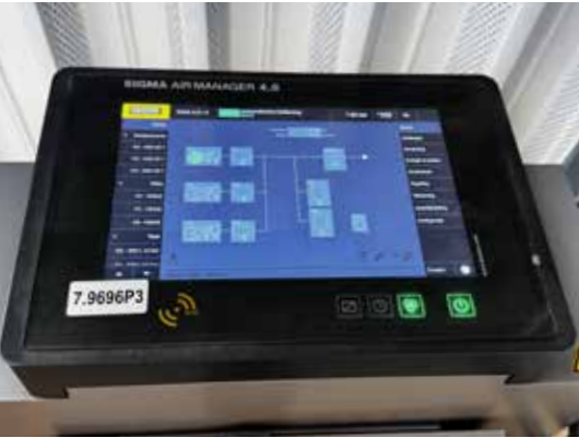
El SIGMA AIR MANAGER 4.0 procura un funcionamiento eficiente y un reparto homogéneo de la carga entre todos los compresores.
