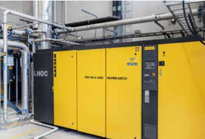
Fotografía inferior izquierda: Tres compresores de tornillos de dos etapas y libras de aceite DSG 180-2 con secador i.HOC integrado. Fotografía inferior derecha: El SIGMA AIR MANAGER 4.0 es uno de los motivos por los que Ringnes optó por una estación de aire comprimido KAESER.
