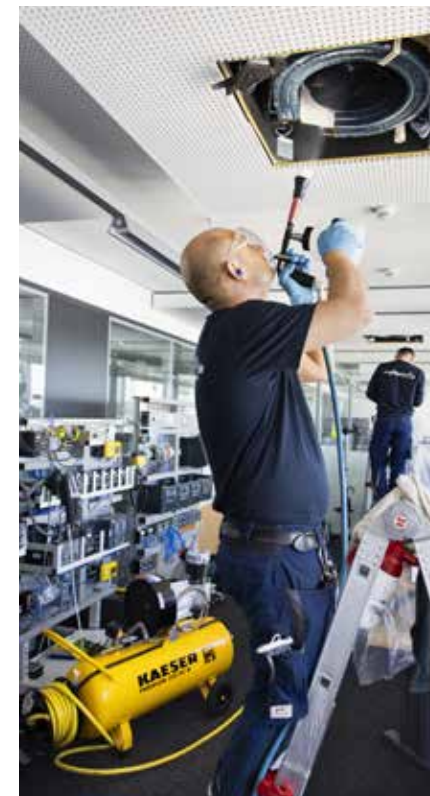
Izquierda: El camión Eisschmitt transporta el compresor MOBILAIR y los aparatos necesarios para la limpieza por criogenización. Derecha: Intervención en la central de KAESER en Coburg: limpieza de los conductos de ventilación.
